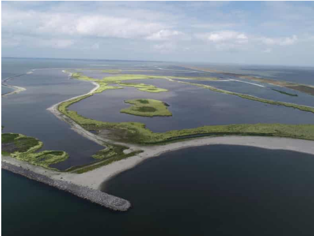
Figuur 1.2 Luchtfoto deel Trintelzand A (voorground) en B (achtergrond), juni 2021.
