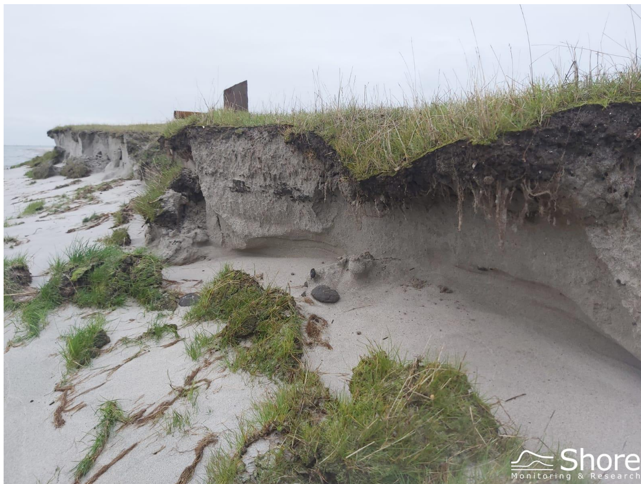
Figure 6.17: Klifvorming IJsselmeerkant nabij Enkhuizen (D1- west), kijkend richting oosten
