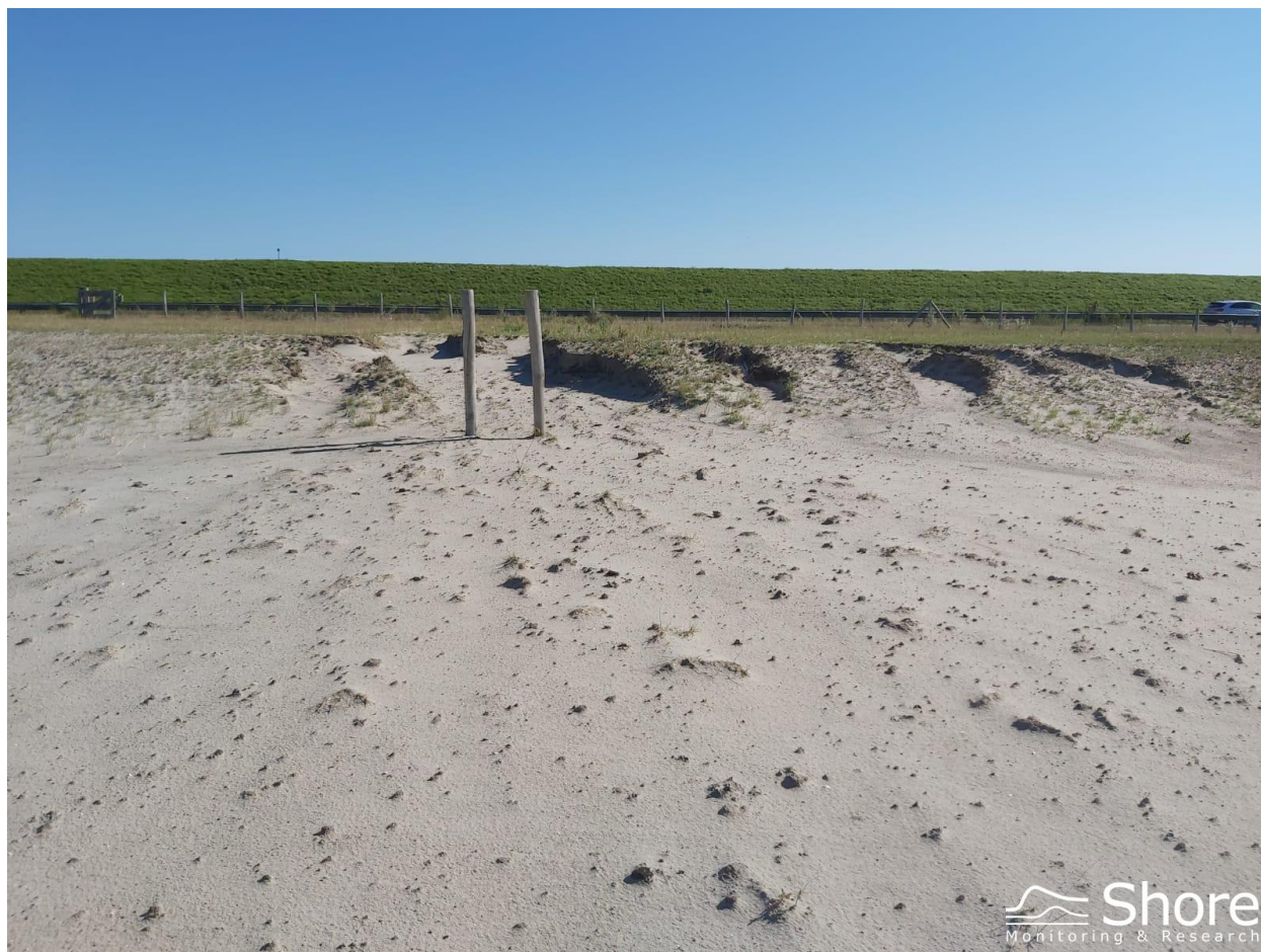
Figure 6.14: Eroderende kleilaag, ook zand wordt meegevoerd, door regenafvoer. MMzijde.
