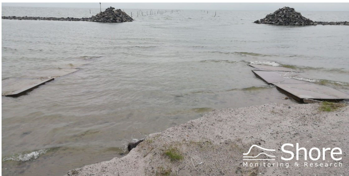
Figure 6.1: Stelconplaten boven de waterlijn.
