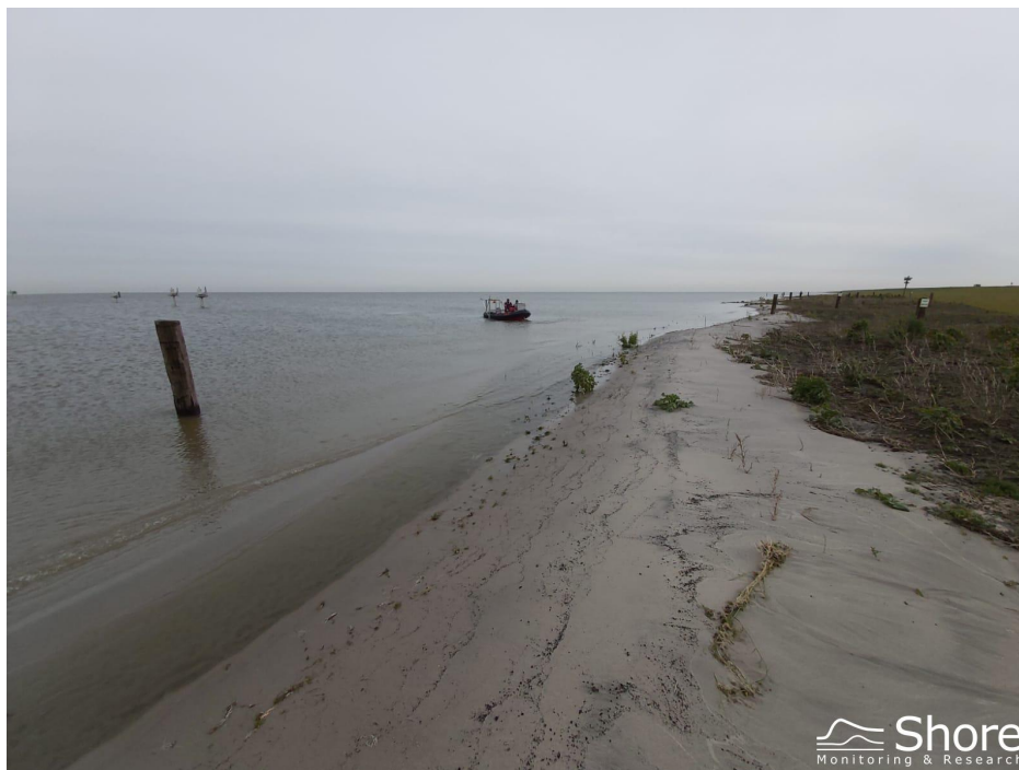
Figure 6.1: Pingboot heeft tot zeer dicht bij de waterlijn goede data (Detail 1)
