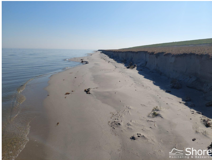
Figure 6.5: IJsselmeerzijde, erosie van de zandige dijkversterking. Waar nabij Enkhuizen een klif ontstaat van circa 1 meter hoog
