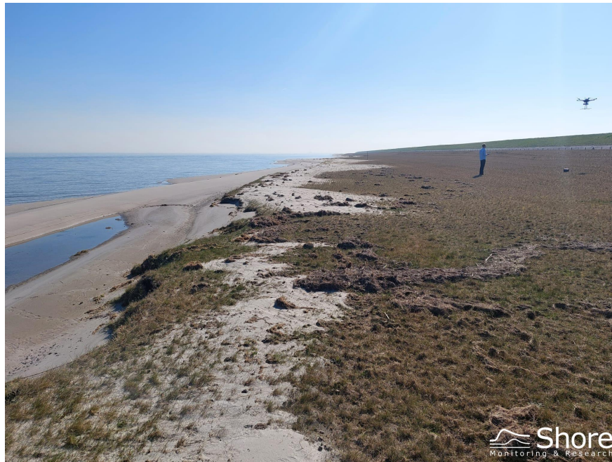
Figure 6.3: IJsselmeerszijde, erosie van de zandige dijkversterking.
