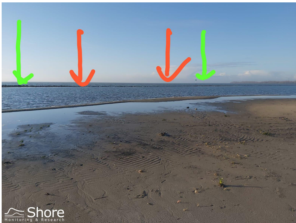
Figure 6.9: Waarneembare hoogtevariati es in de vooroeverdam ten westen van de boothelling bij D4. De rode pijlen geven de verlaging aan t.o.v. de delen aangewezen met de groene pijlen.
