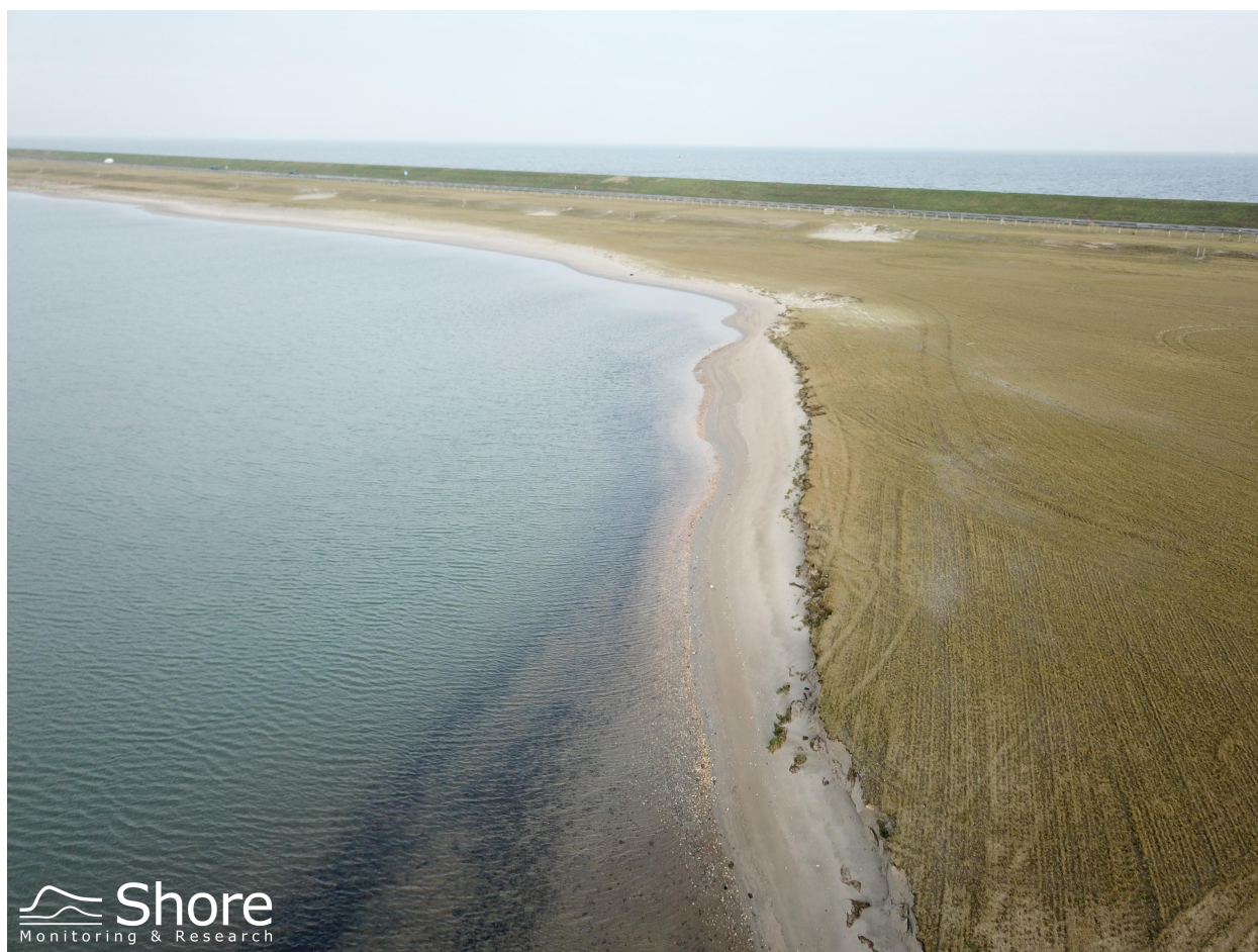
Figure 6.24: D3. Scarp westzijde van dam.
