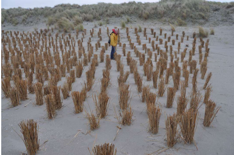
Figuur 6: Vak D, in september 2017 ingepoot. Op dat moment is lokaal tot wel 20 cm ingezand (vergelijk de zichtbare lengte van de rietpoten). De langste nog boven het zandoppervlak uitstekende riet poten zijn ca. 50 cm hoog. Als verwacht nog geen vegetatie-vestiging. (Foto: Bert van der Valk, 14 nov 2017).
