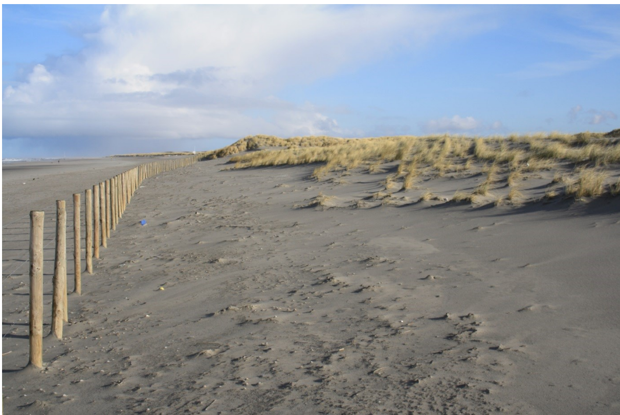
Figuur 2-2 Zeewaarts verplaatst hekwerk aan de voet van het noordelijke basisduin. Dit basisduin is in 2013 aangeplant met meanderend helm. [Foto: Marjon Paas, Royal HaskoningDHV, februari 2015]
