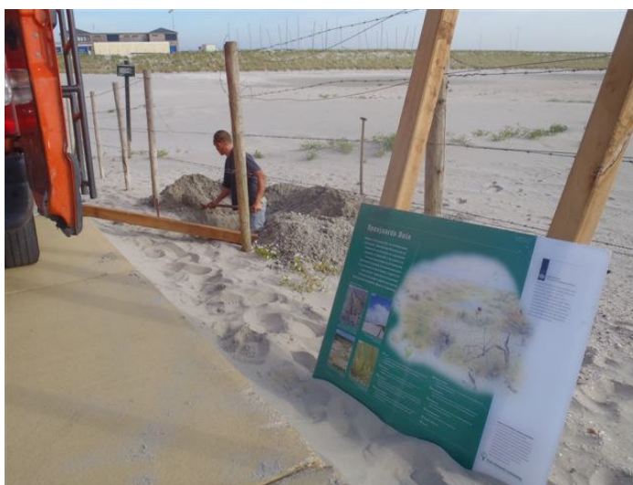
Plaatsing informatiepaneel, voorjaar 2011, foto Niek Koppelaar
