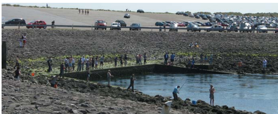
Foto 3.1: Vissers op de sluis in de Brouwersdam (foto CSO img_0503)
